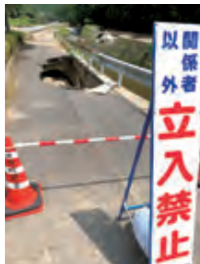
川の氾濫によって削られた歩道 (上) 各地で土砂災害も発生 (下)
